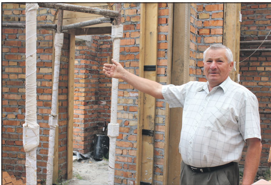
Депутат Байковецької сільської ради Василь Козак під час будівництва церкви Преображення Господнього.
