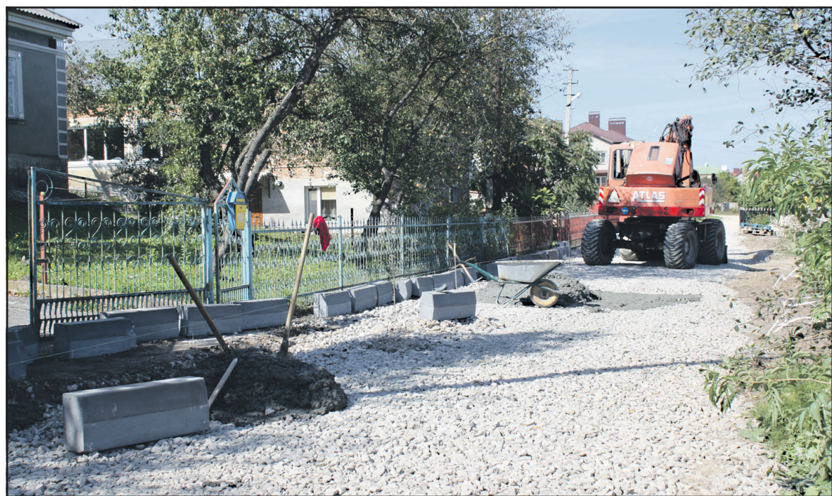
Триває капітальний ремонт вулиці Трудова у с. Байківці.
