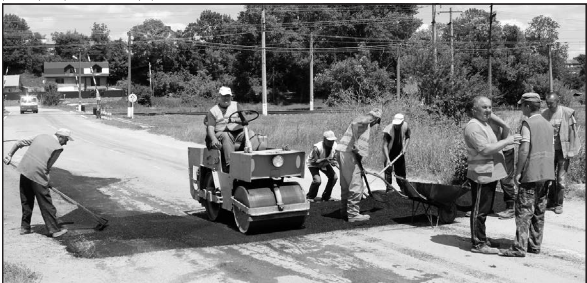
У ремонті автомобільної дороги С-201501 Об'їзна Великий Глибочок-Осташівці задіяно дві бригади дорожніх майстрів філії «Тернопільський райавтодор».
